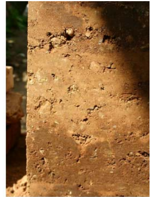
Esempio di compattazione di un setto in terra battuta, eseguito durante il
