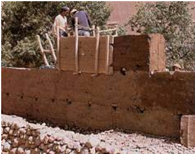
Marocco muro in "pisé de terre"
