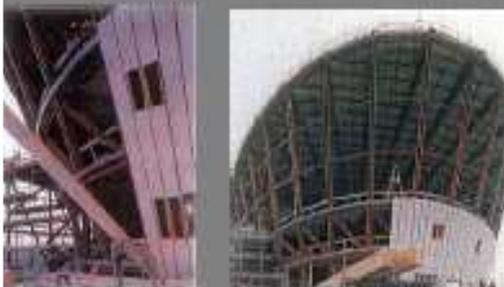
5. La gobbia metallica strutturale 7. Vista dall'interno 8-9. La posa dei pannelli compositi modulari ancorati ai soffi, tramite elementi in acciaio ad alle
