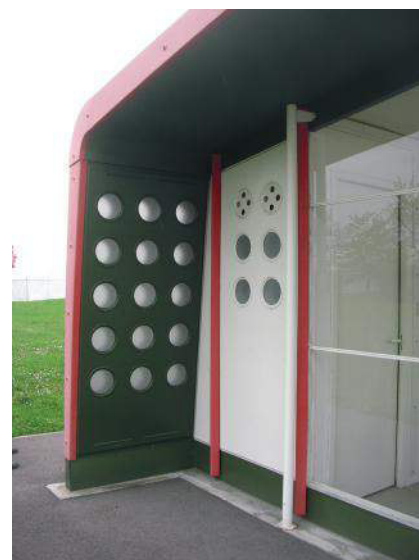
Jean Prouvé, Campus Vitra, Weil am Rhein (Germania) . Stazione di servizio prefabbricata e smontabile progettata in serie (progetto: 1953, realizzazione: 2003)
