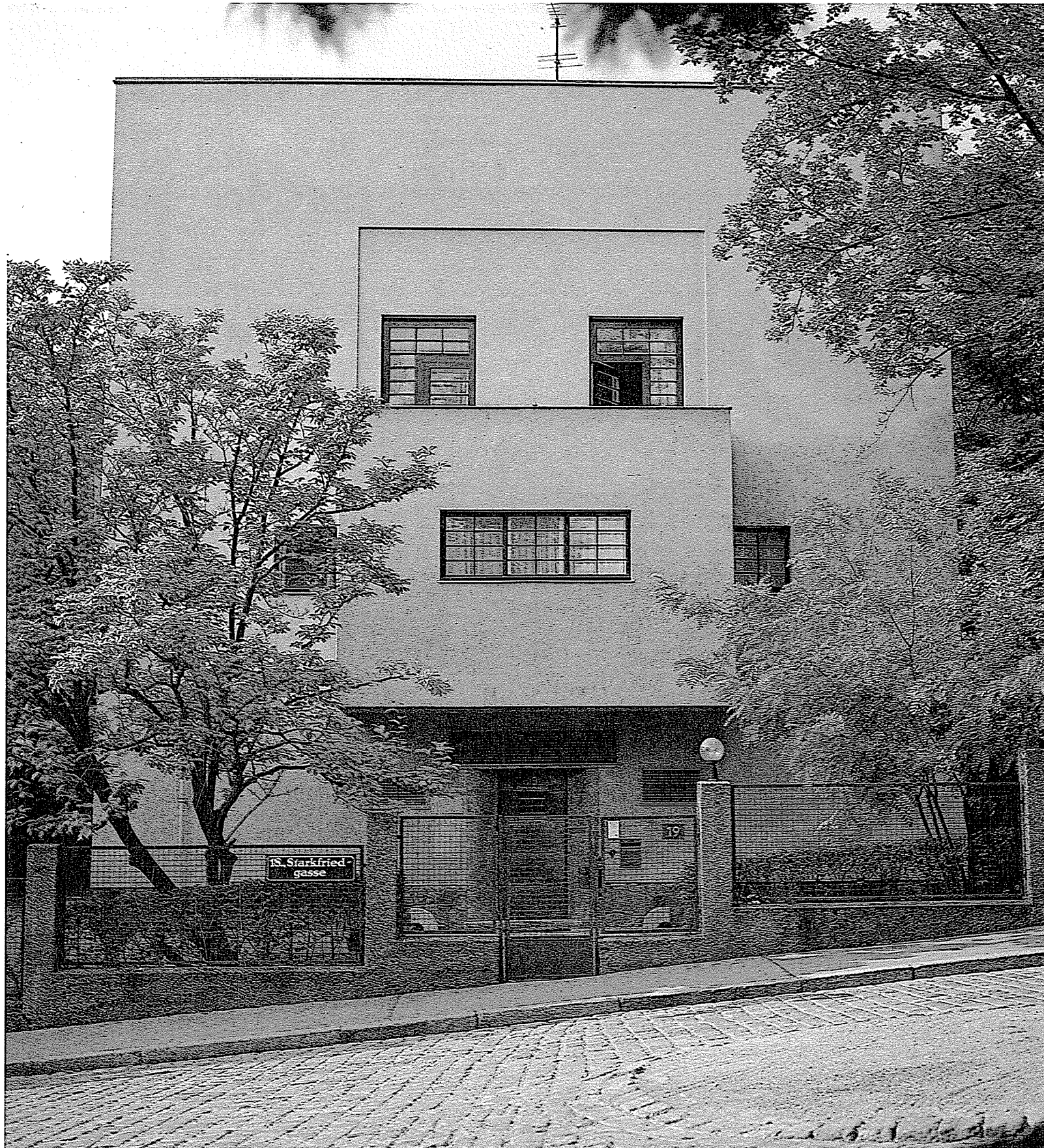
La facciata nello stato attuale.
