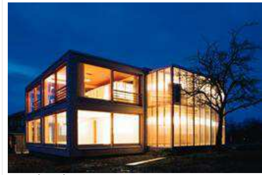
Fig. 146: fotografia esterna notturna
