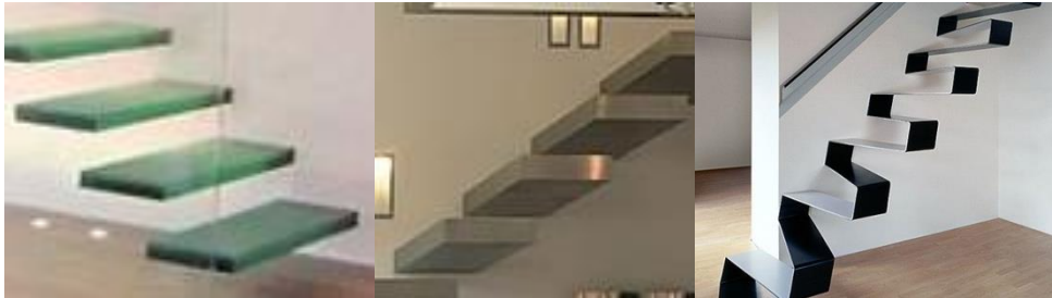
gradini a sbalzo prefabbricati
