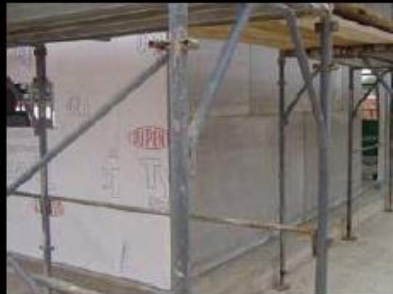
I gusci sono definiti da **lastre leggere** avvitate su sottostruttura in acciaio.
