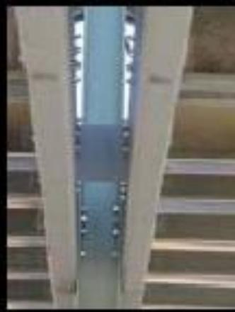
La **parte portante** del solaio è costituita da travetti in acciaio pressopiegato e da un pannello in legno. Il peso della parte strutturale è di appena **40 Kg/m<sup>2</sup>**.
